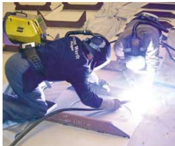
▲ Schweißarbeiten am SUBS
