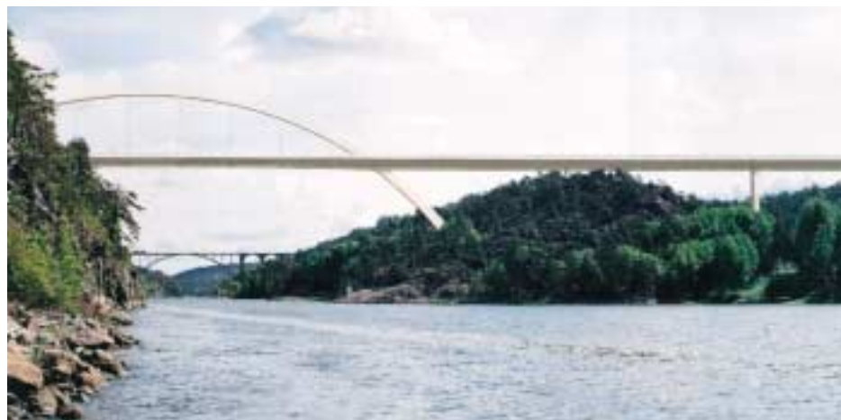
700 m lange Brücke über den Svinesund, Schweden (3D Animation)
